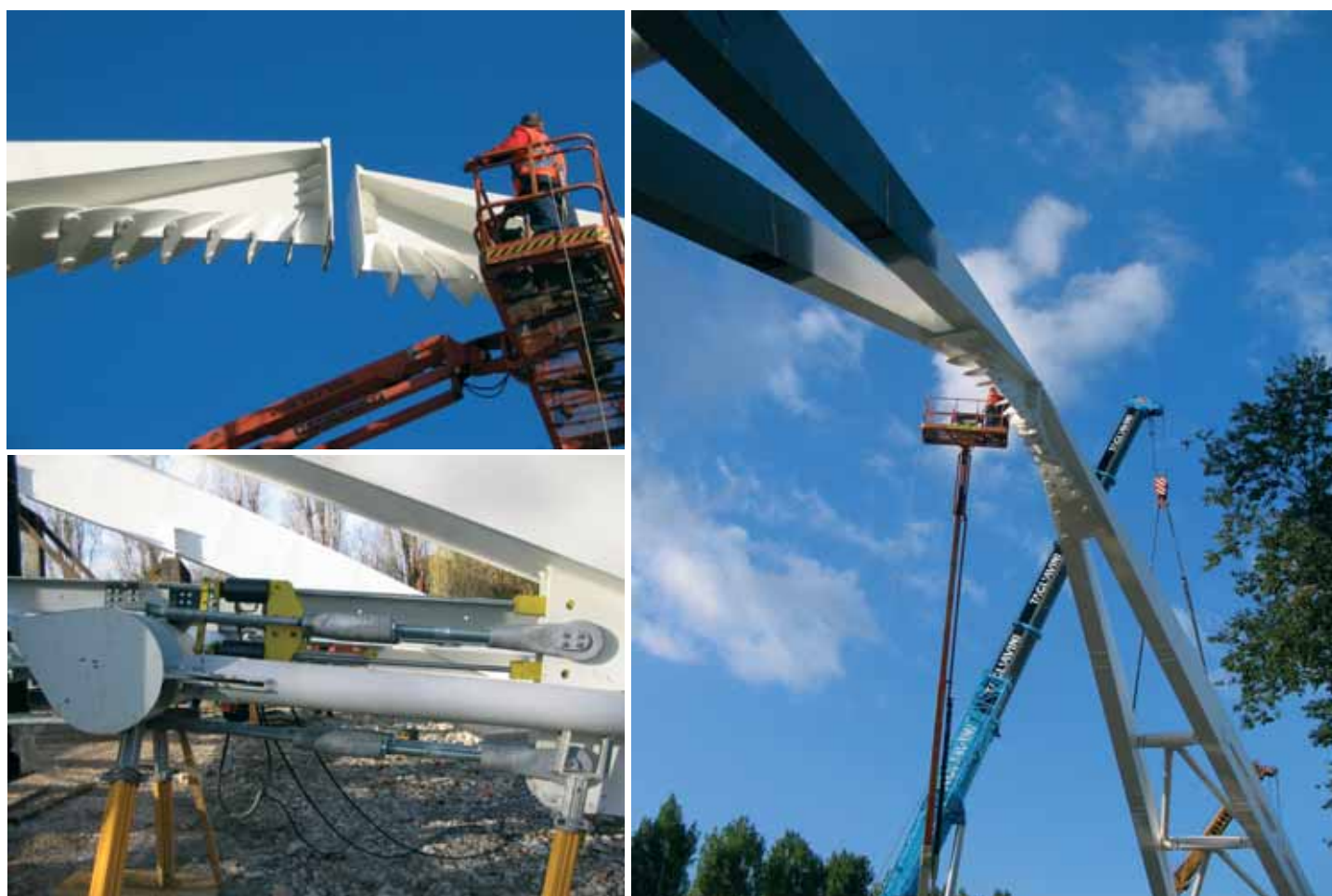
Fig.13 - Operazioni di montaggio in chiave e posizionamento dei martinetti sulle funi stabilizzanti
