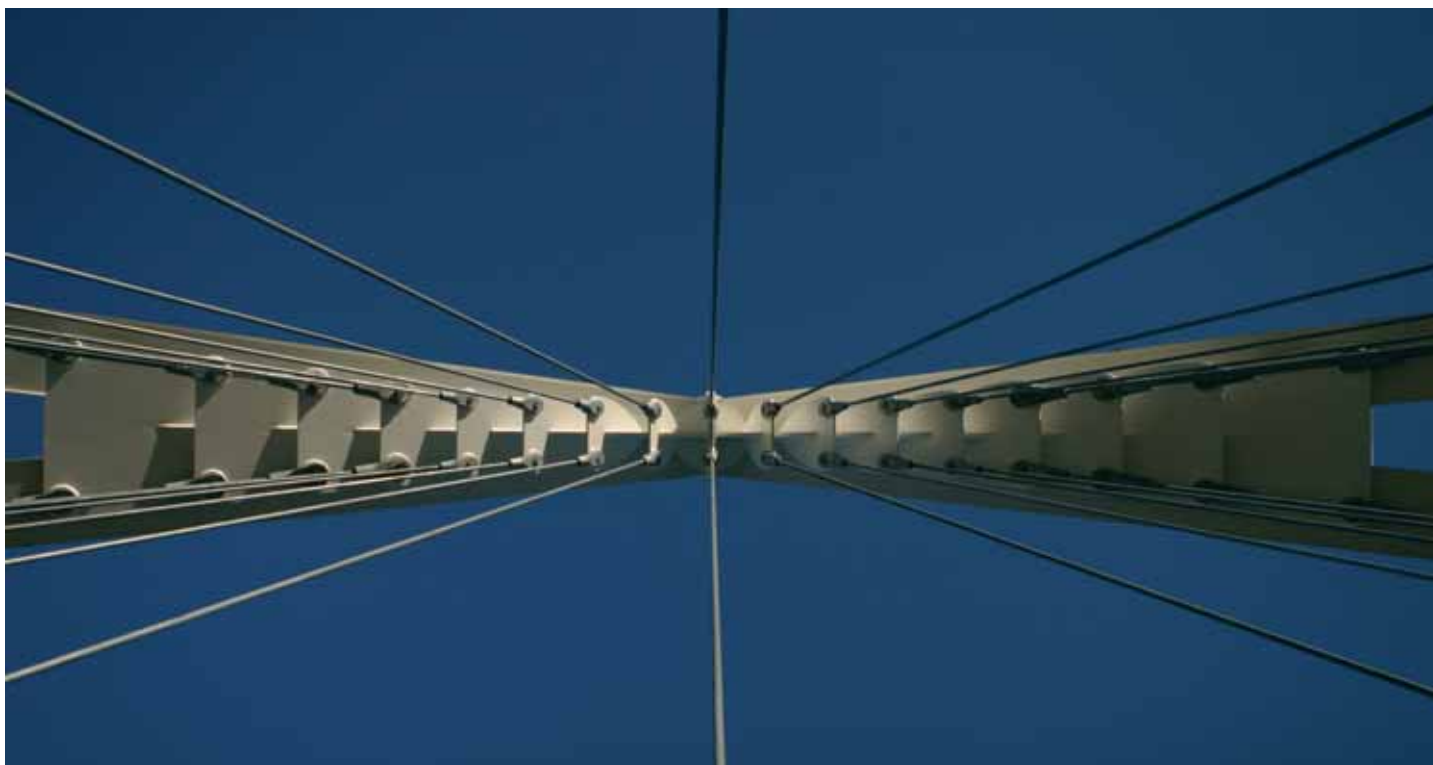
Fig. 1 - Ancoraggio in chiave degli stralli radiali
