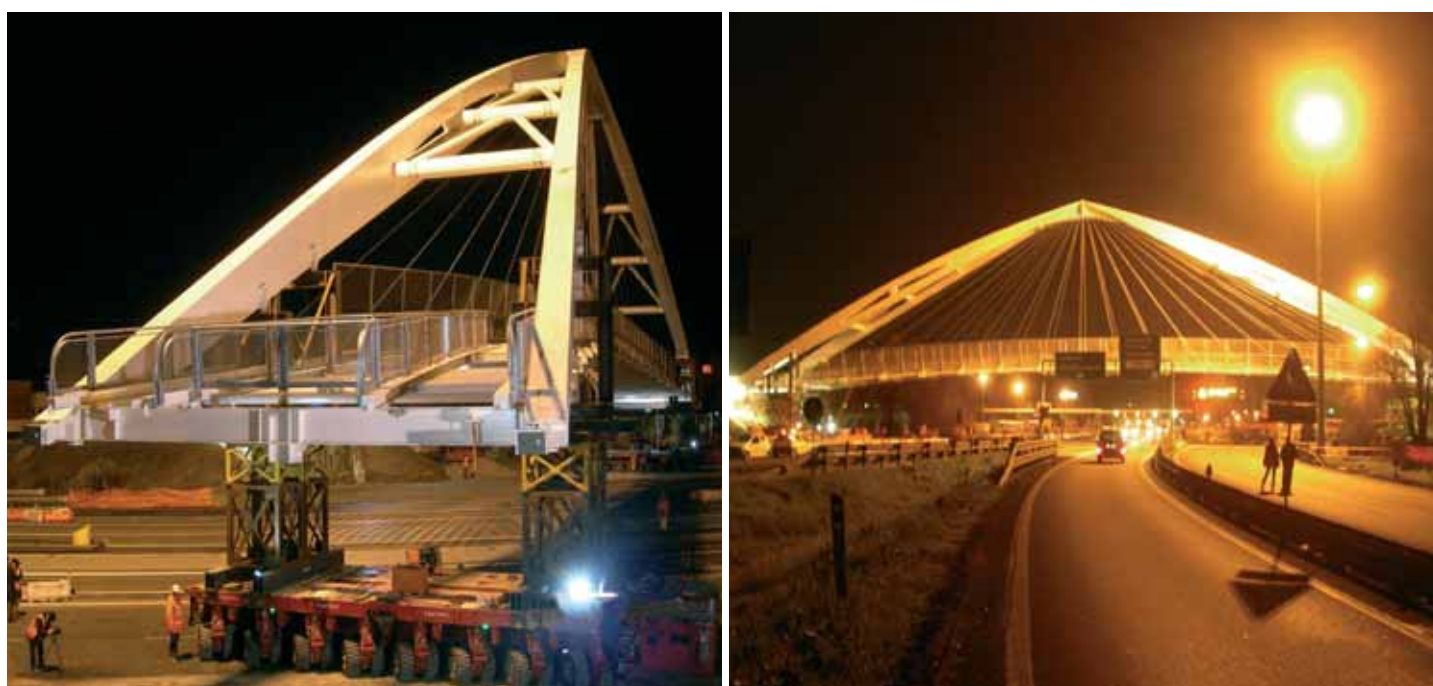
Fig.15 - Movimentazione su carrelli
