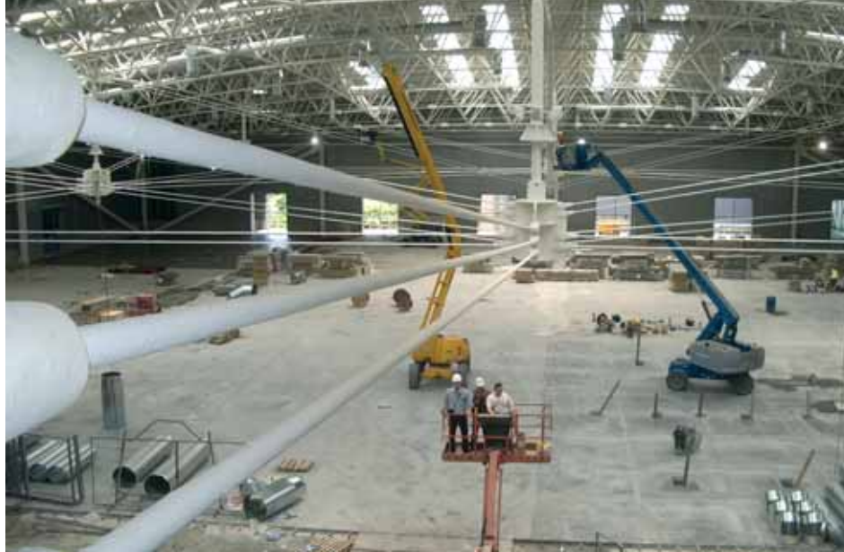
Fig. 25 - Struttura reticolare spaziale una volta rimossi gli appoggi provvisori
