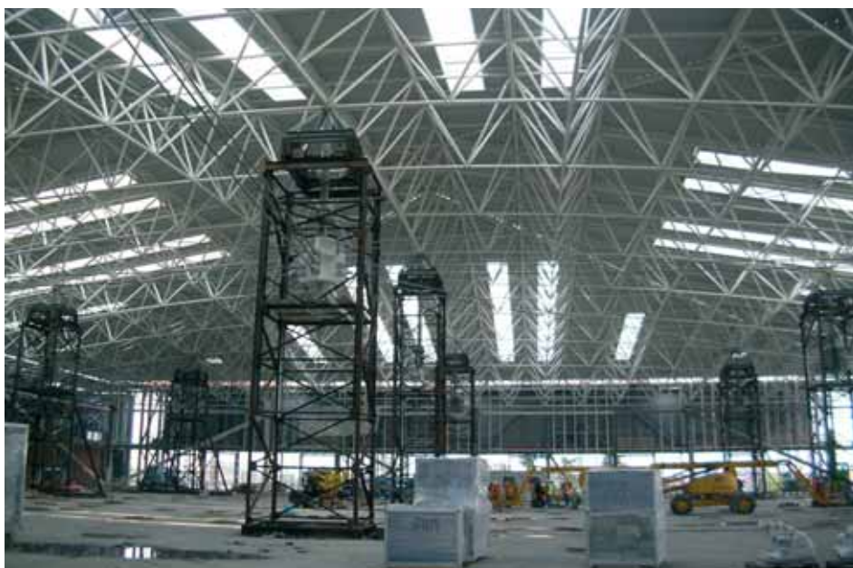
Fig. 15 - Posizionamento degli appoggi provvisori sotto la struttura reticolare in corrispondenza dei puntoni
