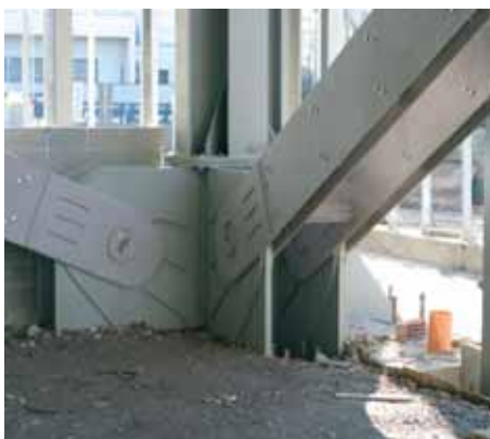
Fig. 9 - Attacco dei diagonali di controventamento
