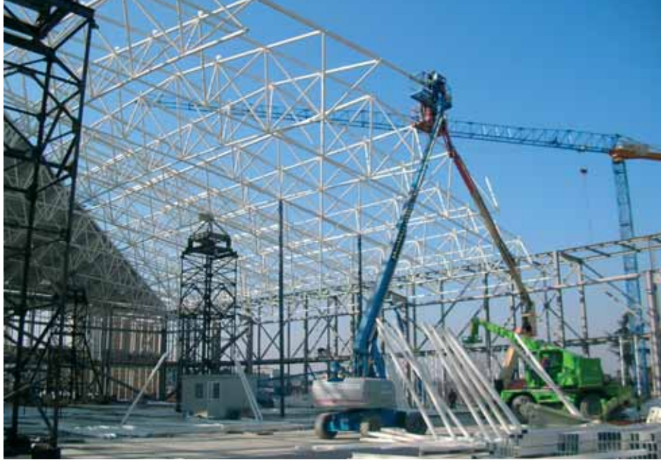
Fig. 13 - Montaggio dei moduli di reticolare
