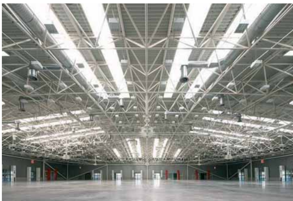
Fig. 29 - Vista della reticolare spaziale all'interno del padiglione
