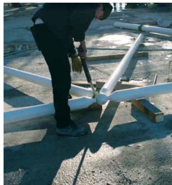
Fig. 12 - Assemblaggio sul solaio a quota +12.00 della struttura reticolare
