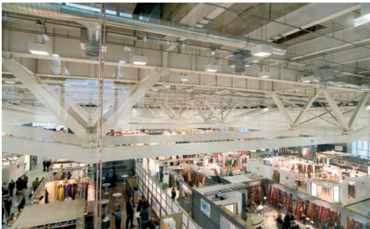
Fig. 18 - La trave spaziale formata accoppiando due travi piane e dei montanti a V
