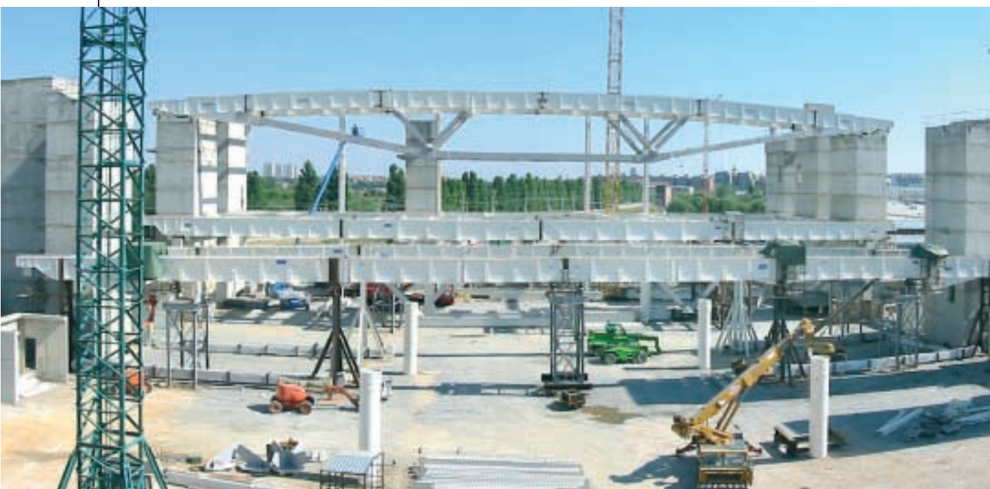
Fig. 11 - Fase di costruzione delle travi spaziali appoggiate in sommità alle 'torri' dei vani scala in cemento armato
