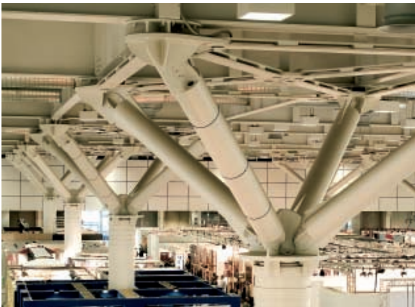
Fig. 14 - Vista delle colonne portanti miste acciaio-cemento armato del corpo C
