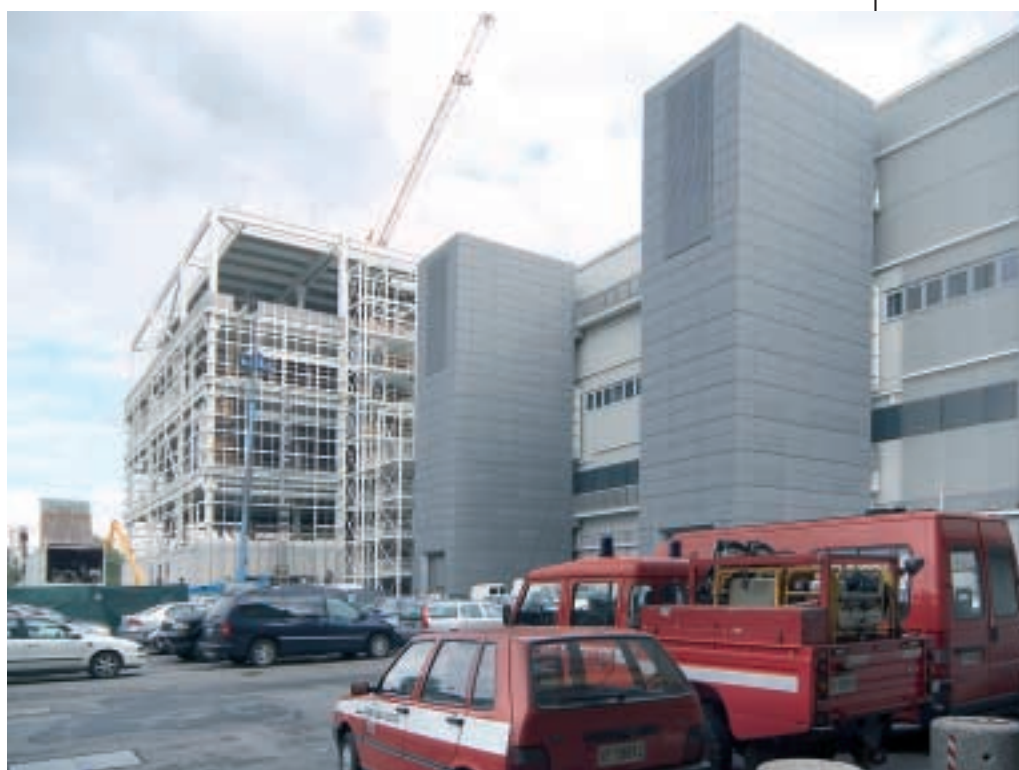
Fig. 8 - Vista del fronte ovest e del corpo B in fase di costruzione
