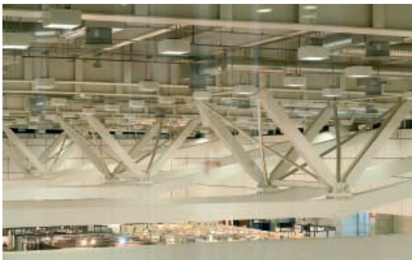
Fig. 17 - Vista della trave spaziale della copertura
