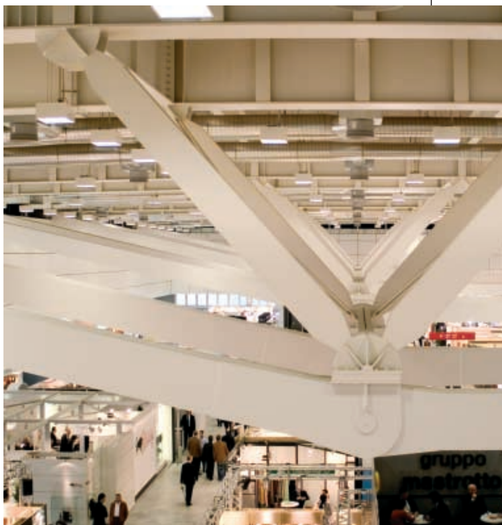
Fig. 16 - Vista della trave spaziale della copertura
