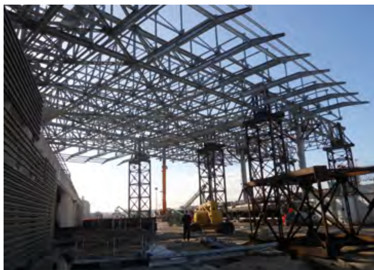
Fig. 6 - Costruzione della struttura reticolare di copertura sorretta da appoggi provvisori e posizionamento della lamiera
