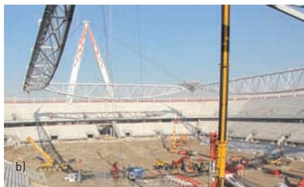
Figura 19 - a) Cavalletto ad A in posizione per il sollevamento e torre provvisoria, b) Sollevamento delle travi principali
