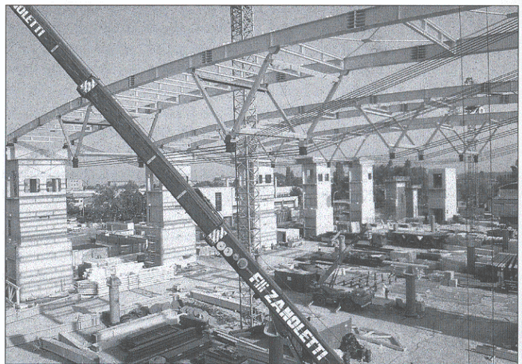
Fig. 8 Campata tipo: dettagli capriata copertura.
