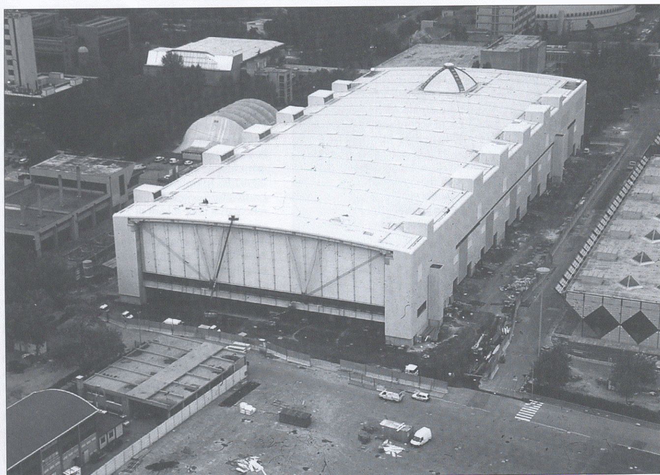
Fig. 4 Vista aerea dal lato Nord.
