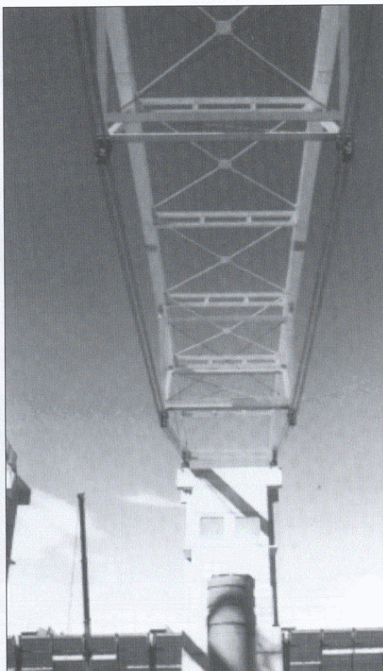
Fig. 3 La trave armata di copertura.
