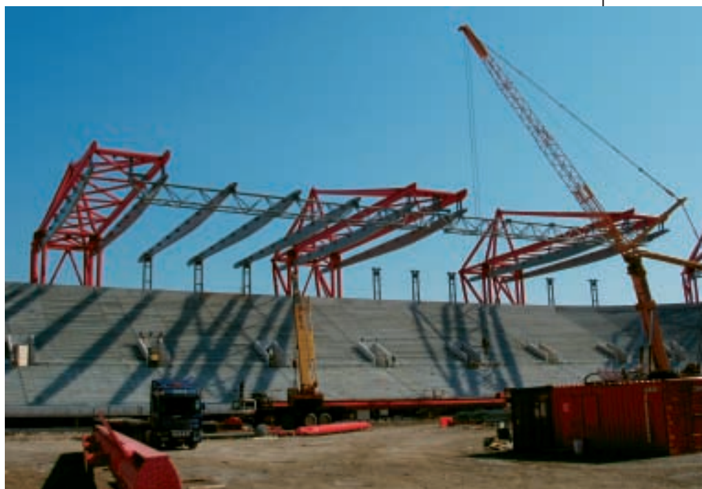
Fig. 18 - Montaggio delle strutture secondarie di copertura nella zona ovest
