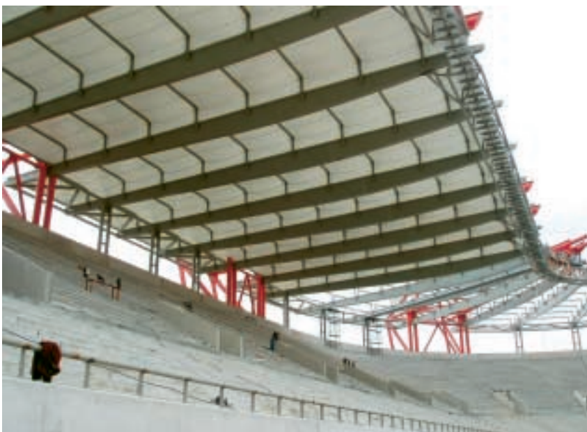
Fig. 19 - Montaggio di un modulo di copertura
