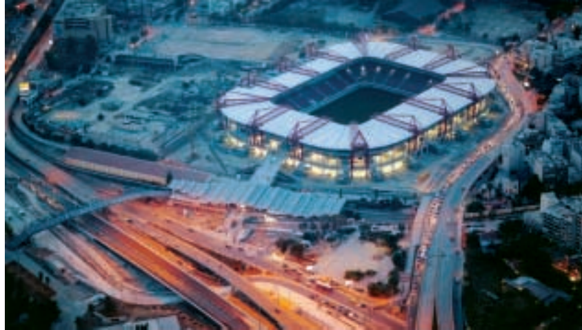
Fig. 21 - Vista complessiva della copertura
