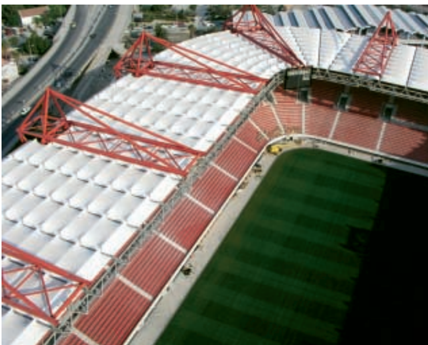
Fig. 20 - Vista dall'alto della copertura ultimata
