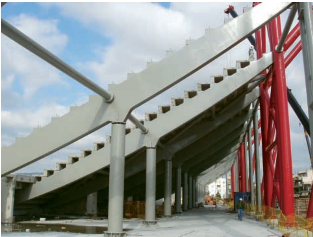
Fig. 17 - Montaggio delle gradonate
