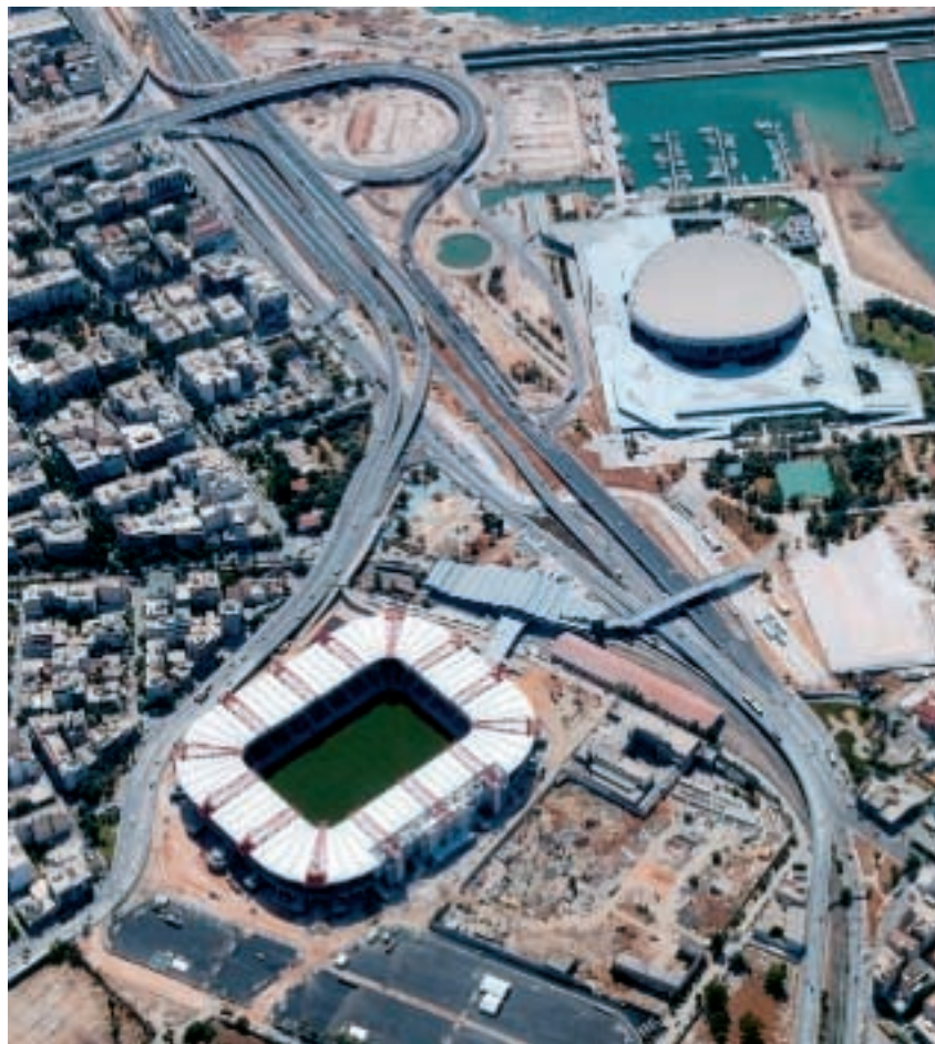
Fig. 22 - Vista aerea dello Stadio Karaiskakis con adiacente il palazzo dello sport e dell'amicizia
